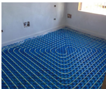
Riscaldamento a pavimento alimentato da caldaia a condensazione per il massimo del comfort e del risparmio.
