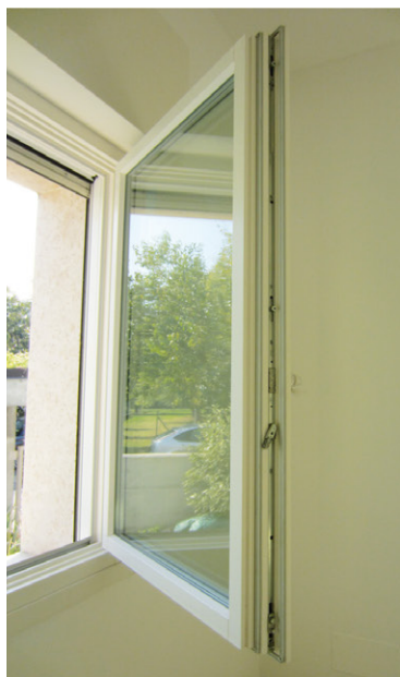
Serramenti con triplo vetro e doppia camera ad elevate prestazioni.
